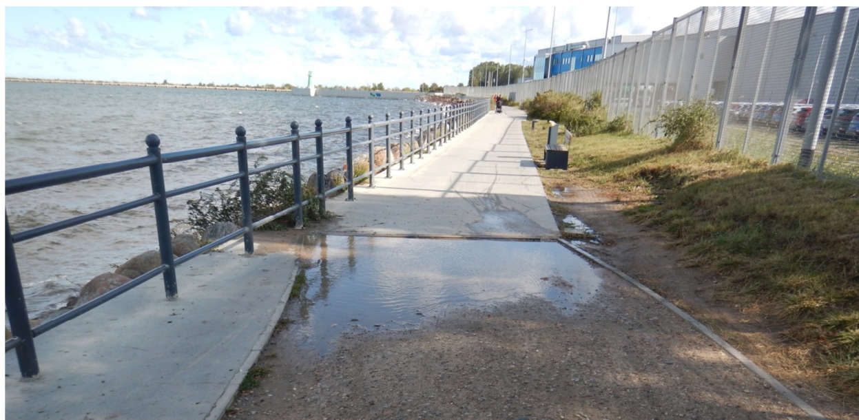
Fot 3. Połączenie ścieżki o nawierzchni gruntowej ze ścieżką o nawierzchni betonowej. Widoczne zagłębienie, w którym gromadzi się woda opadowa oraz uszkodzenia skarpy i zieleni w rejonie tego zagłębienia.
